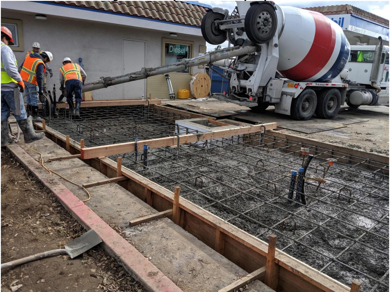
Figure 6: Sunnyvale Concrete pad pour
