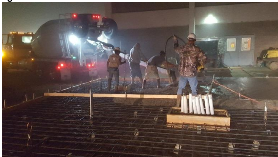
Figure 24: Conduit Placement Installed and BESS Concrete Pour
