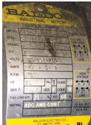
Figure 203: Fan Motor Nameplate
