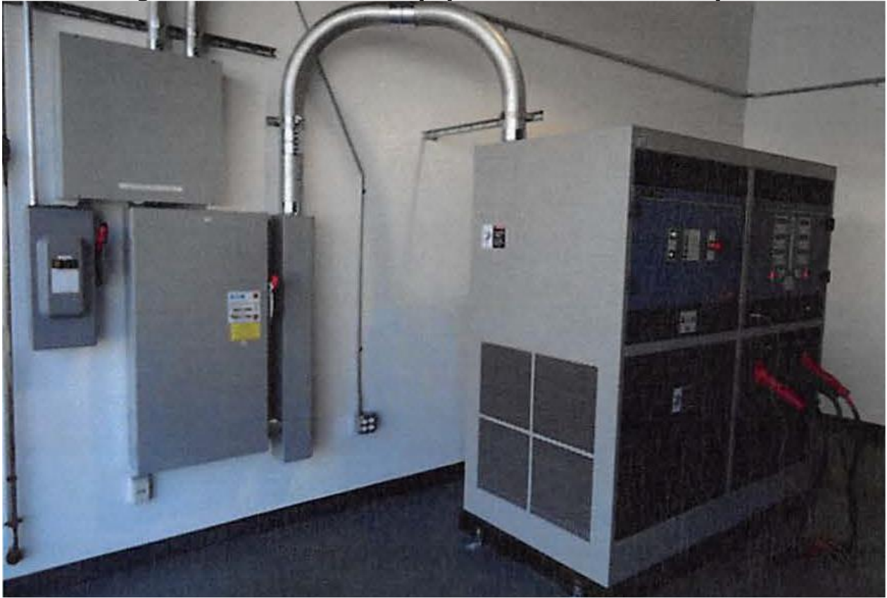
Figure 5: AV 900 HV Lab Equipment Installation Complete
