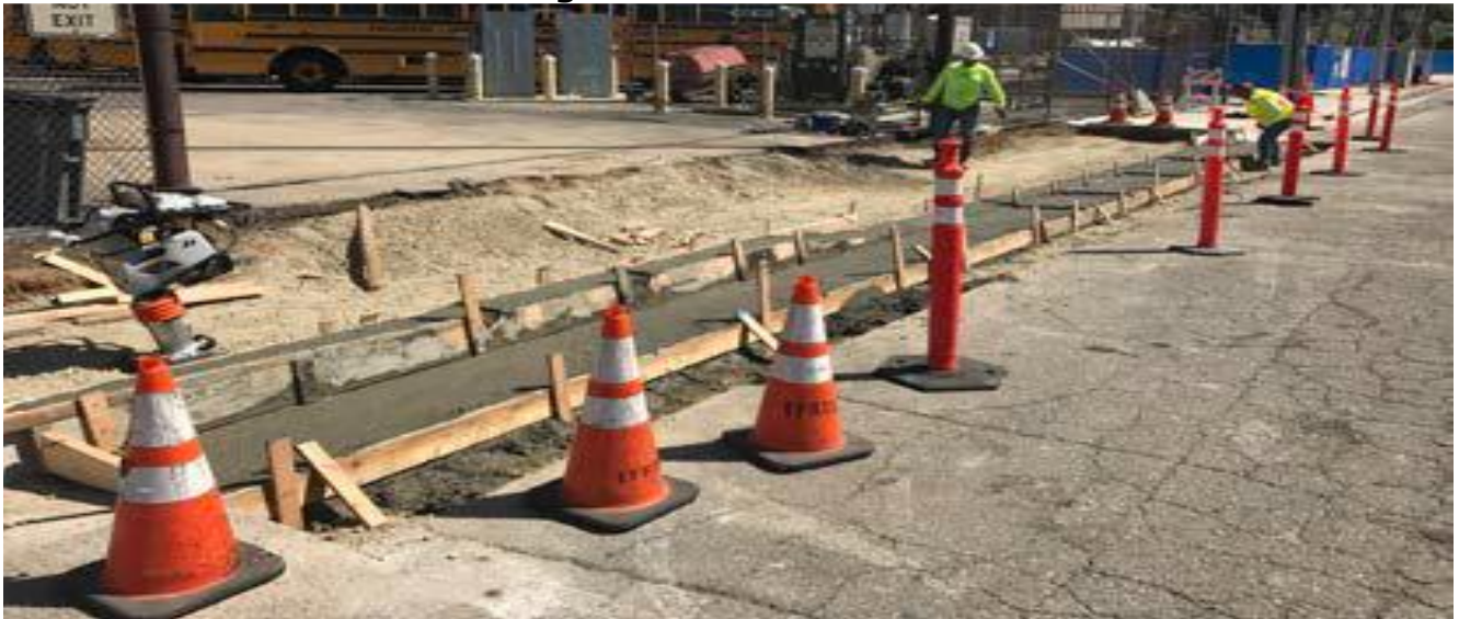
Figure 7: Concrete Pour
